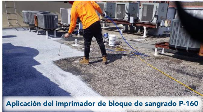
Aplicación del imprimador de bloque de sangrado P-160
